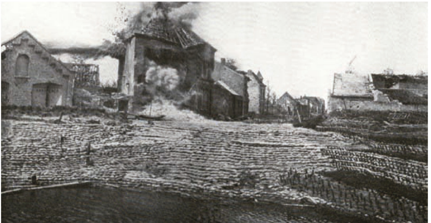
■ Een nooddam op het kanaal Nieuwpoort-Duinkerke op het moment van een bominslag (Kristof Jacobs, Nieuwpoort Sector 1917)
